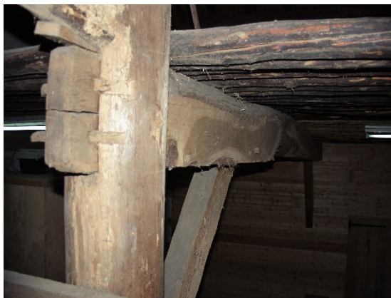
44 – 45. De eiken ankerbalk van het eerste gebint (boring 05) leverde helaas geen jaartal op. Vanwege de overeenkomsten met het exemplaar uit 1526 (o.a. wat betreft het formaat van het gat voor het korbeel) is een hoge leeftijd ook hier niet uitgesloten.
