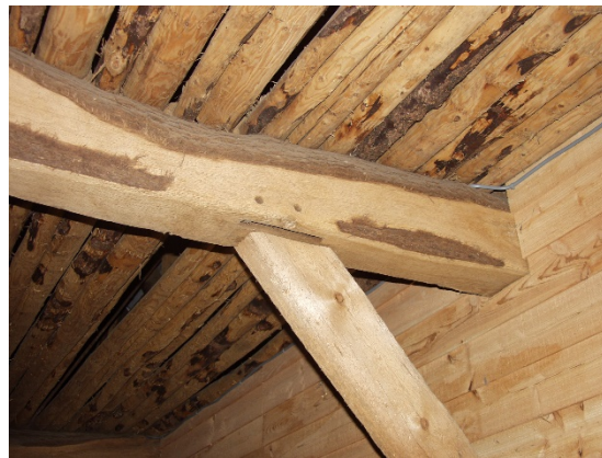
44 – 45. De eiken ankerbalk van het eerste gebint (boring 05) leverde helaas geen jaartal op. Vanwege de overeenkomsten met het exemplaar uit 1526 (o.a. wat betreft het formaat van het gat voor het korbeel) is een hoge leeftijd ook hier niet uitgesloten.
