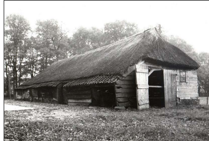
16 – 17. Foto's uit 1972. Boven: in de deuropening is de verdwenen gaffelvormige ankerbalk te zien. Onder: de mestdeurtjes in de zijgevel zijn bij de 'restauratie' van 1986 verdwenen.
