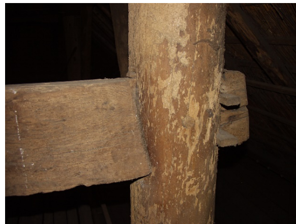
27- 30. De ankerbalk van het vijfde gebint is vervaardigd uit een eik geveld in 1526 (boring 02) en hergebruikt in een grenen constructie uit circa 1865.
