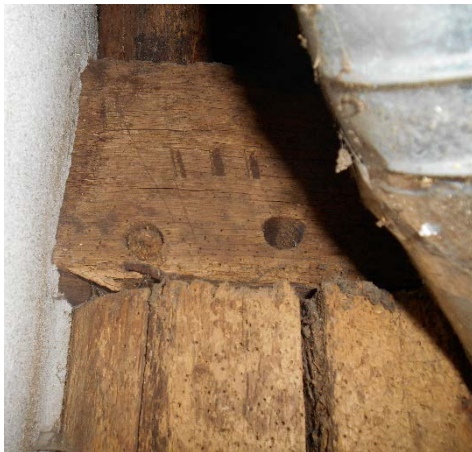
39 – 41. Gehakte telmerken op de gebintplaat uit 1791, achtereenvolgens het eerste deel met III, en het tweede deel met IIIII en IIIII. Een niet-kloppende reeks waaruit blijkt dat één van de twee segmenten oorspronkelijk aan de overzijde zat.
