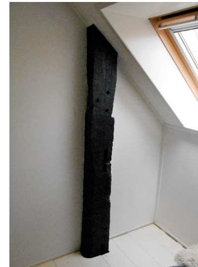
36. Steunbalk gebintplaat oostzijde (boring 10).
