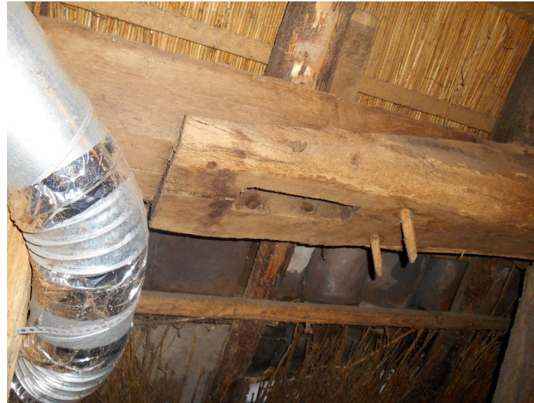
37- 38. De ruim 7 meter lange gebintplaat, afkomstig van een eik geveld in 1791 (boring 01), hergebruikt in de grenen constructie uit 1865.
