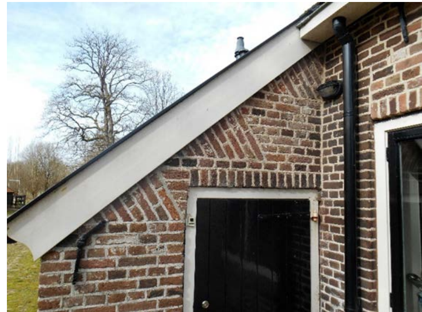
63. Anders dan aan de westzijde bezit de kubbing aan de oostzijde vlechtingen. Het bovenste exemplaar wordt deel bedekt door de zijmuur van het woongedeelte. Bewijs voor een oudere bouwfase? Of zijn de vlechtingen aangebracht bij de restauratie in 1986? Het nieuwe voeg- en inboetwerk heeft de bouwsporen hier weggewist. Op oude foto's is het muurtje steeds uit het zicht.
