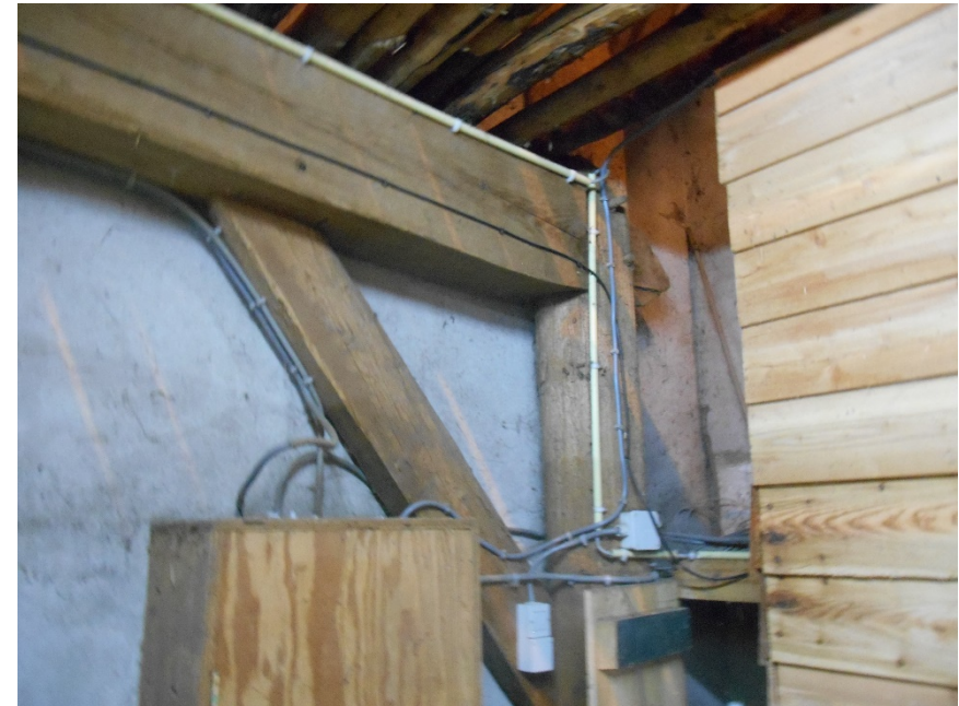
44 – 45. De eiken ankerbalk van het eerste gebint (boring 05) leverde helaas geen jaartal op. Vanwege de overeenkomsten met het exemplaar uit 1526 (o.a. wat betreft het formaat van het gat voor het korbeel) is een hoge leeftijd ook hier niet uitgesloten.
