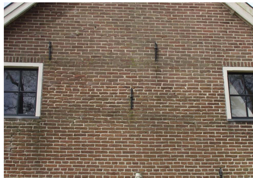
64 – 65. Op de zwart-witfoto zijn in het metselwerk van de voorgevel goed de verschillende bouwfases waarneembaar. Met name ter hoogte van de zoldervensters bevindt zich een band metselwerk met een afwijkende steen (vechtmaat).
