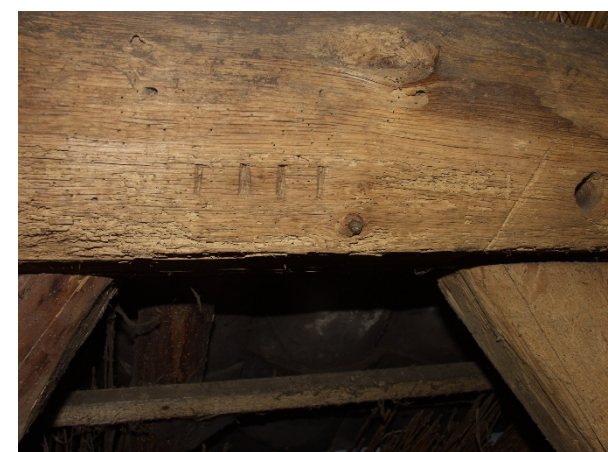
39 – 41. Gehakte telmerken op de gebintplaat uit 1791, achtereenvolgens het eerste deel met III, en het tweede deel met IIIII en IIIII. Een niet-kloppende reeks waaruit blijkt dat één van de twee segmenten oorspronkelijk aan de overzijde zat.
