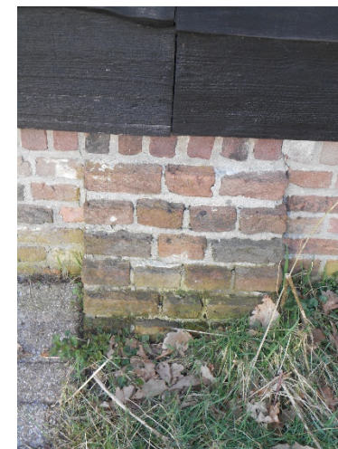
20. Poer in grondmuur.
