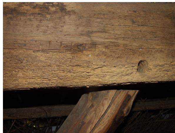
39 – 41. Gehakte telmerken op de gebintplaat uit 1791, achtereenvolgens het eerste deel met III, en het tweede deel met IIIII en IIIII. Een niet-kloppende reeks waaruit blijkt dat één van de twee segmenten oorspronkelijk aan de overzijde zat.
