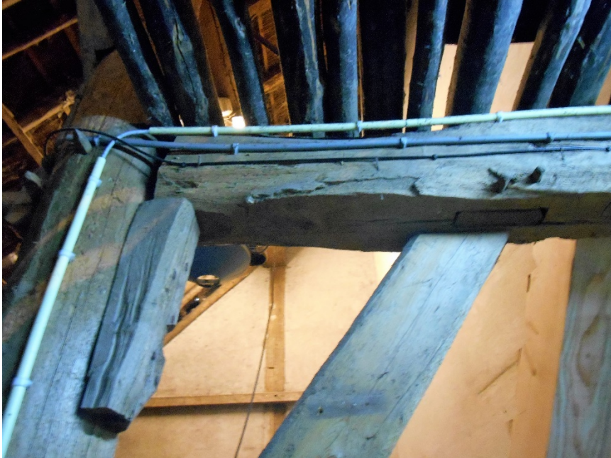
44 – 45. De eiken ankerbalk van het eerste gebint (boring 05) leverde helaas geen jaartal op. Vanwege de overeenkomsten met het exemplaar uit 1526 (o.a. wat betreft het formaat van het gat voor het korbeel) is een hoge leeftijd ook hier niet uitgesloten.
