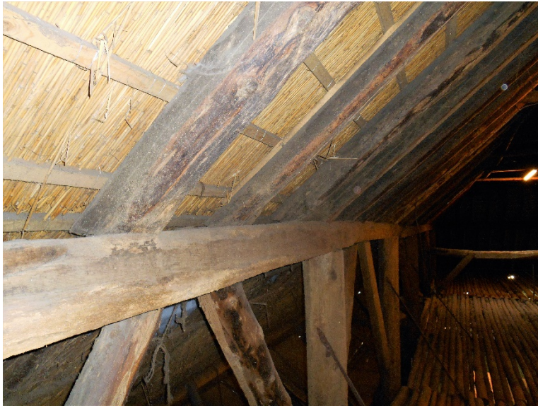
37- 38. De ruim 7 meter lange gebintplaat, afkomstig van een eik geveld in 1791 (boring 01), hergebruikt in de grenen constructie uit 1865.
