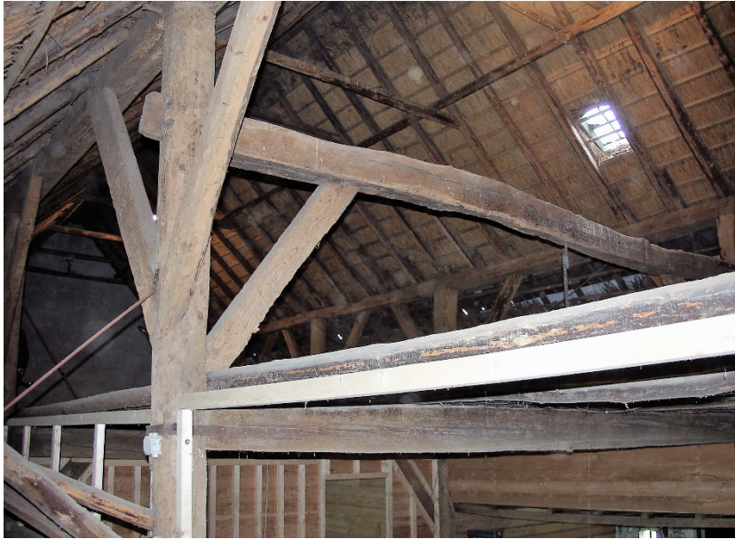
12. Het stalinterieur ter hoogte van het vijfde etagegebint.
