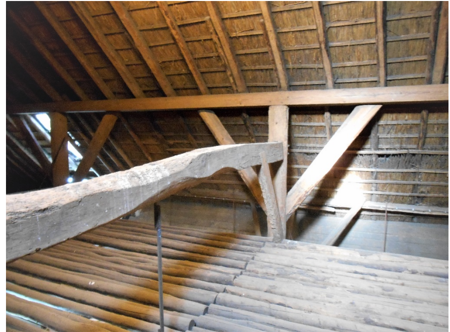
27- 30. De ankerbalk van het vijfde gebint is vervaardigd uit een eik geveld in 1526 (boring 02) en hergebruikt in een grenen constructie uit circa 1865.
