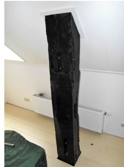
35. Steunbalk gebintplaat westzijde (boring 9).
